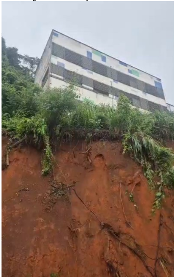
Figura 5 - Vista do escorregamento de talude a partir de uma das residências vizinhas ao Colégio
