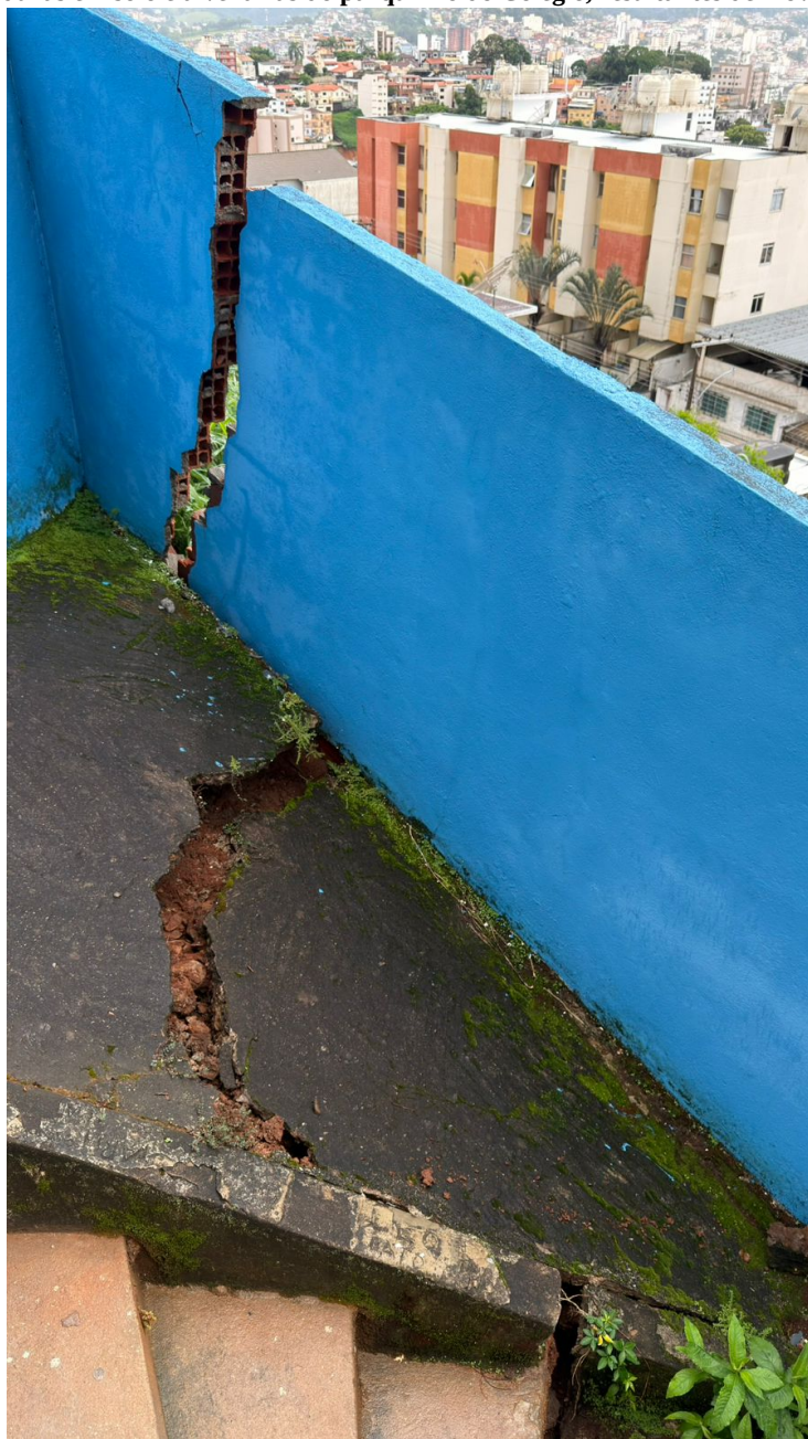
Figura 4 - Rachaduras em solo e alvenarias do parquinho do Colégio, resultantes de movimentação do solo
